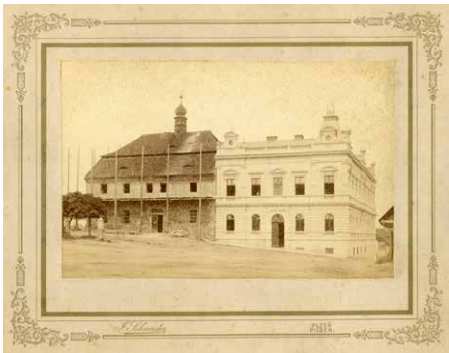
Obrázek číslo 1: Černobílá fotografie staré budovy blovické radnice před přestavbou a okresního soudu. Dátováno 1893. (Sbírka Muzea jižního Plzeňska v Blovicích, p. o.)
