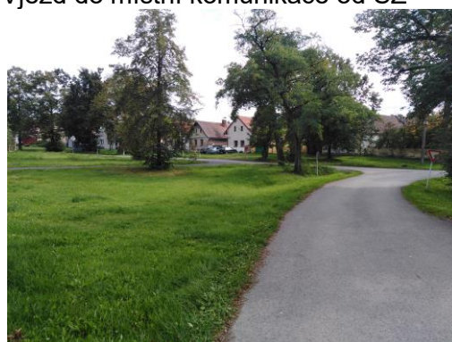
Vyústění místní komunikace do II/117
