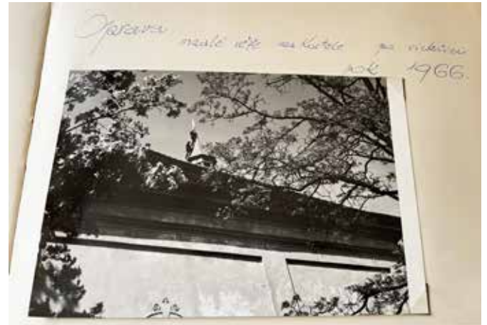
Oprava střechy blovického kostela v r. 1966
