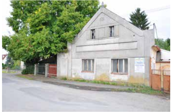
Podoba objektu hostinec U Redlichů před demolicí v roce 2017. Foto: MJP v Blovicích, p. o.
