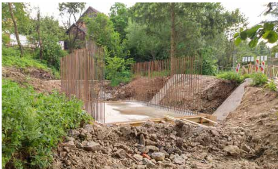
Staré koryto bylo přehrazeno a mostní těleso je betonováno „na sucho“. Cementové výluhy tak nemohou unikat do koryta. Foto: P. Vlach
