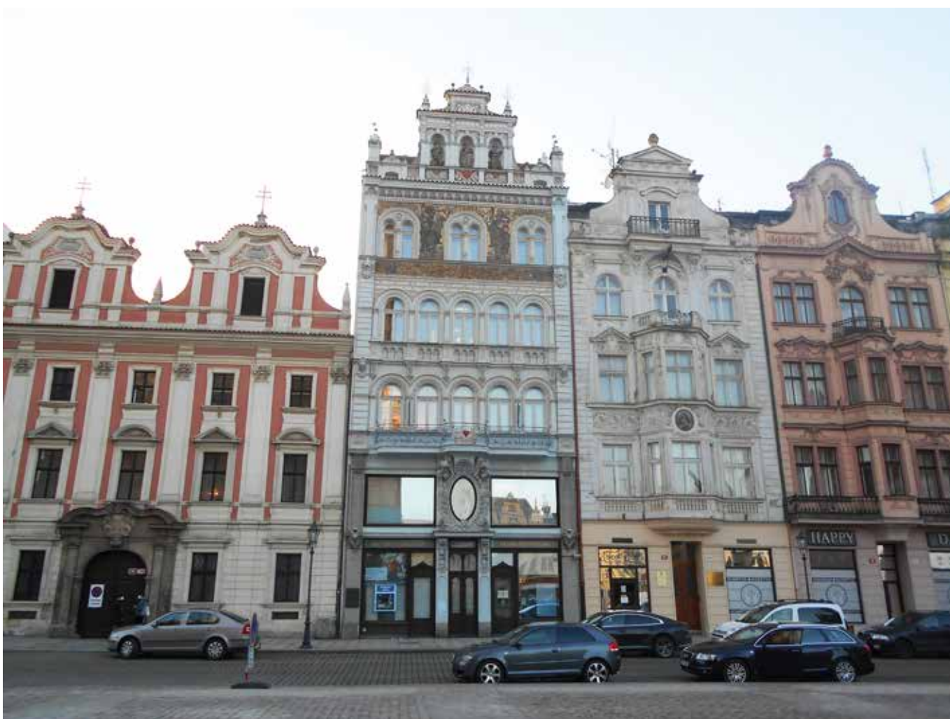
obr. č. 2 – dům U Červeného srdce (druhý zleva)
