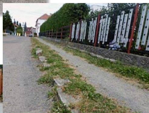
ulice Bečvářova před rekonstrukcí
