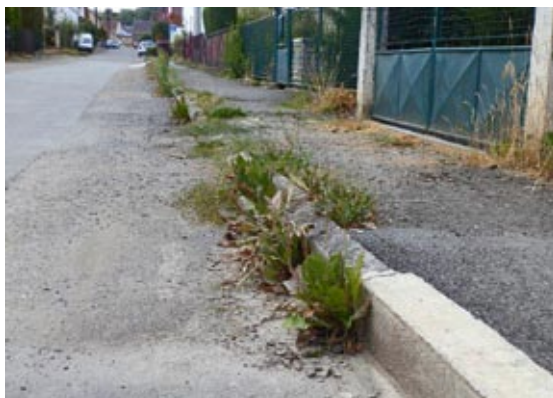
ulice Pod Rybníčkem před rekonstrukcí
