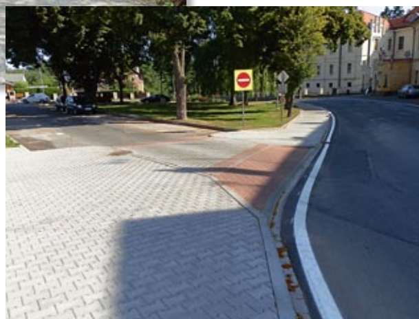
dokončený chodník na Hradišti v místě častých dopravních nehod
