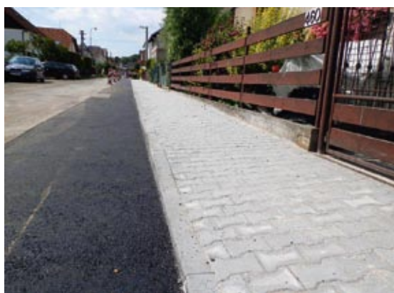
ulice Pod Rybníčkem po rekonstrukci
