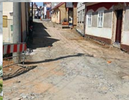
právě probíhající rekonstrukce Pobrežní ulice
